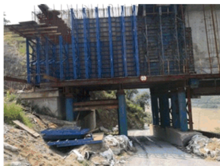
图 13 边跨现浇段非对称悬臂施工
