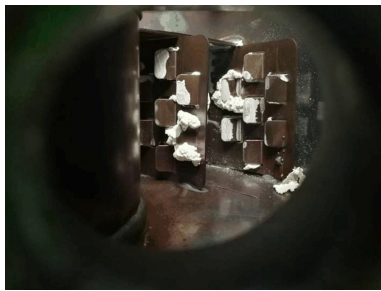
图 14 原 SCR 系统的尿素结晶
