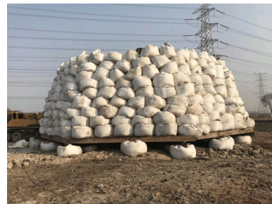
图 1 现场堆载试验图片
