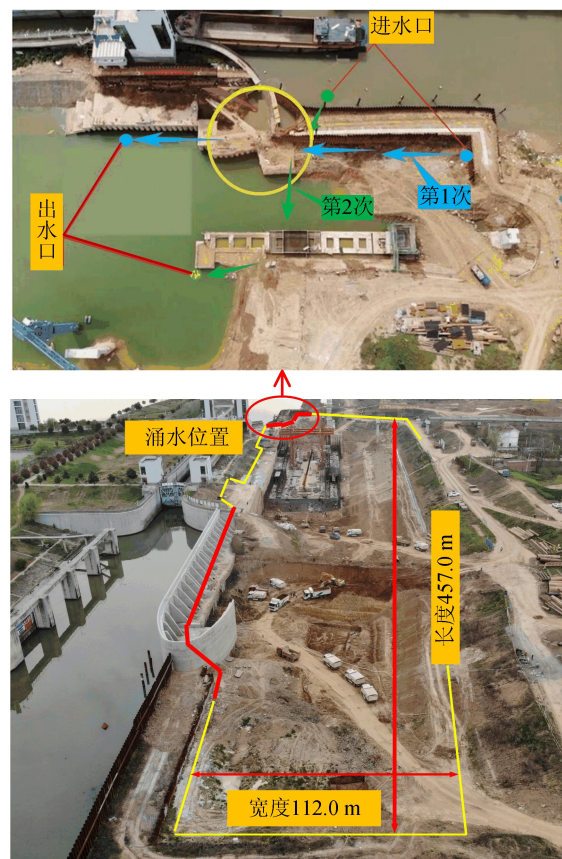
图 1 船闸基坑现场及涌水路线图
